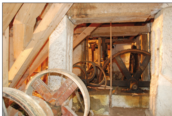
Obr. 12. Kunžak (JH) mlýn čp. 113. Interiér přízemí mlýnice. Foto J. Pešta, 2010.
