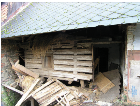
Obr. 8. Radešice čp. 9, vodní mlýn zvaný Jedličkům. Levá část jižního – dvorního průčelí jádra domu, roubené přízemí mlýnice již zaniklé. Foto 2005.
