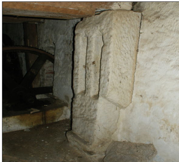
Obr. 4. Mlýn čp. 113 v Kunžak (JH). Zadní kamenný sloupem mlýnské hranice s dvěma drážemi pro lehčení. Foto R. Urbánek, 2010.
