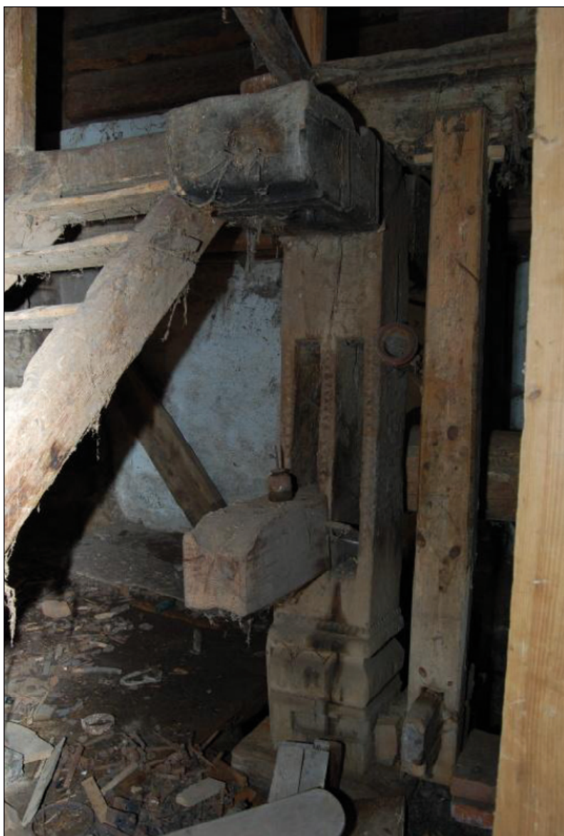
Obr. 32. Hubenov čp. 9, vodní mlýn. Mlýnská hranice před demontáží. Foto 2009.
