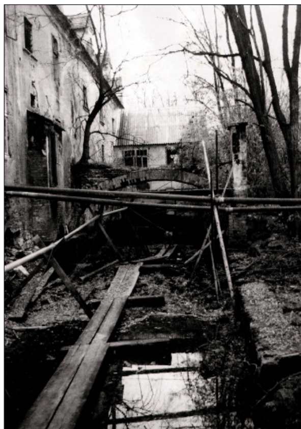
Obr. 18. Slup (ZN). Návodní strana mlýna na počátku sedmdesátých let 20. století. V pozadí je viditelný turbínový domek odstraněný během rekonstrukce. Archiv Technického muzea v Brně.
