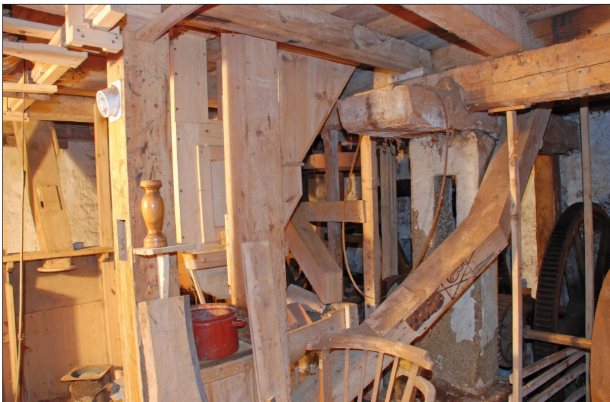
Obr. 13. Kunžak (JH) mlýn čp. 113. Interiér přízemí mlýnice. Foto J. Pešta, 2010.
