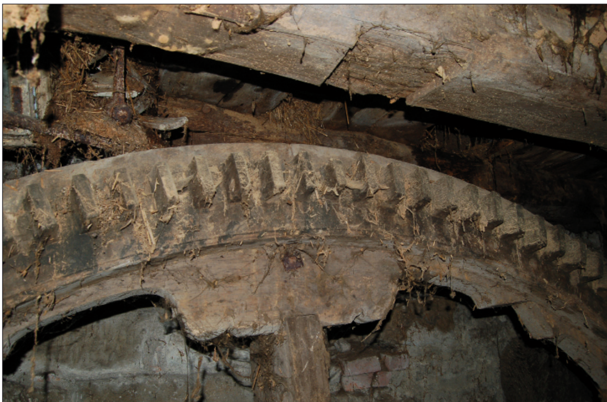
Obr. 15. Turnov, mlýn č. p. 374 (SM), detail tradičního typu palečního kolo s dřevěným profilovaným rámem a oboustrannými čelními dřevěnými palci, foto M. Kolka, 2011.
