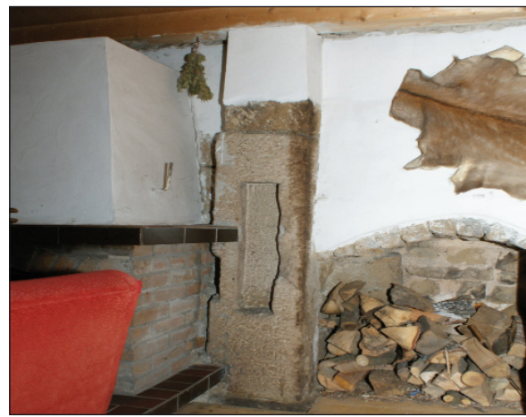
Obr. 6. Mlýn čp. 7 v Dole (NA). Druhotně osazený kamenný sloupky mlýnské hranice sloužící nyní jako dekorace bývalé mlýnice. Foto R. Urbánek, 2011.
