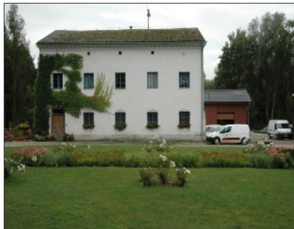
Obr. 2. Velký mlýn v Hlučíně, čp. 404 (OP). Obytná budova mlýnu. Foto K. Jordánová, 2011.
