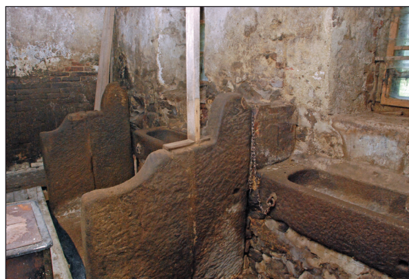
Obr. 16. Kunžak (JH) mlýn čp. 113. Interiér chlěva v jižním křídle s kamennými přepážkami z žulových desek. Foto J. Pešta, 2010.
