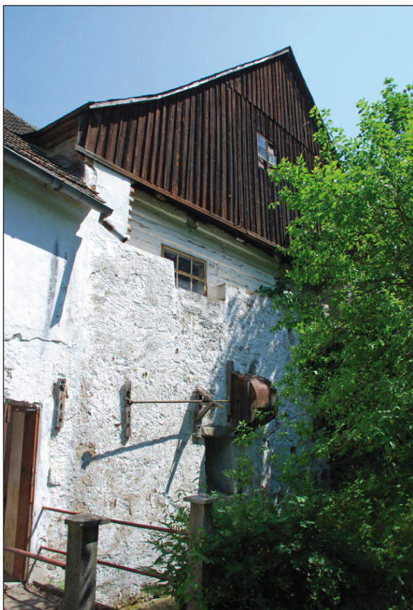
Obr. 10. Kunžak (JH) mlýn čp. 113. Jižní průčelí mlýnice s roubenou vrchní částí. Foto J. Pešta, 2010.
