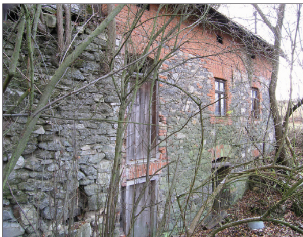
Obr. 20. Radešice čp. 9, vodní mlýn zvaný Jedličkův. Severní průčelí novodobé mlýnice. Foto 2005.
