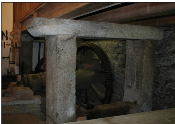
Obr. 7. Mlýn čp. 222 ve Šlakhamrech (ZS). Unikátní případ kamenných sloupů a svorů mlýnské hranice, v popředí střední kamenné sloupy se dvěma drážemi pro lehčení. Foto R. Urbánek, 2011.
