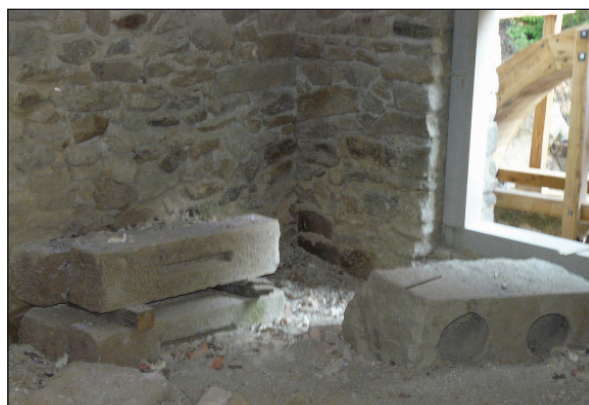
Obr. 2. Kouty čp. (HB). Čtyři demontované kamenné sloupky mlýnské hranice s jednou dráží pro lehčení. Foto F. Mikyška, 2007.
