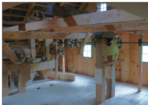
Obr. 19. Týniště čp. 28 (UL). Hlavy výtahů v podstřeší. Foto T. Ledvinka, 2011.
