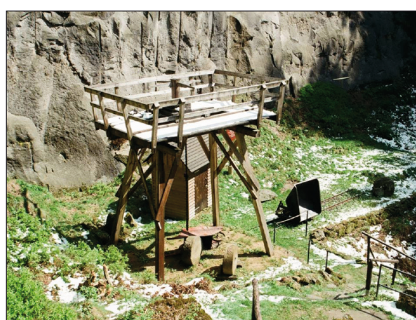
Obr. 12. Lom Johnsdorf, Horní Lužice. Věž pro manipulaci s kameny (jeřáb) – rekonstrukce. Foto F. Ledvinka, 2011.
