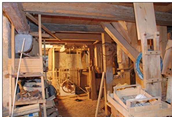
Obr. 11. Kunžak (JH) mlýn čp. 113. Interiér přízemí mlýnice. Foto J. Pešta, 2010.
