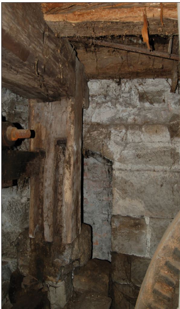
Obr. 11. Turnov, mlýn č. p. 374 (SM), zadní sloup S2 a vztah k zazděné nise v návodní stěně, foto M. Kolka, 2011.
