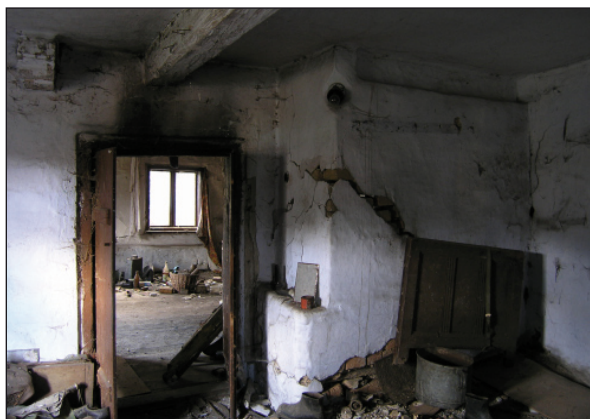
Obr. 11. Radešice čp. 9, vodní mlýn zvaný Jedličkův. Jihozápadní část mladší světnice v severním traktu, pec po posunutí světnice směrem do dvora výrazně vystupuje před její severní (zadní) stěnu (prostor nad pecí je přičleněn k hlavní světnici). Foto 2005.
