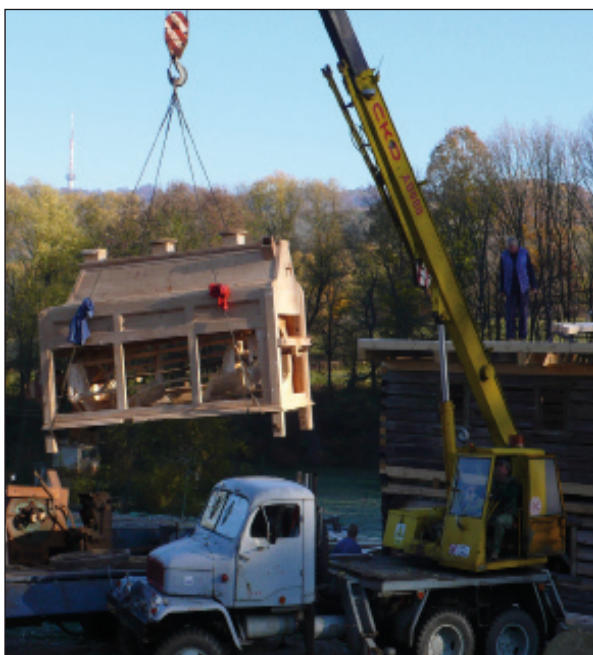
Obr. 14. Týniště čp. 28 (UL). Instalace objemných zařízení před dostavbou. Foto T. Ledvinka, 2007.
