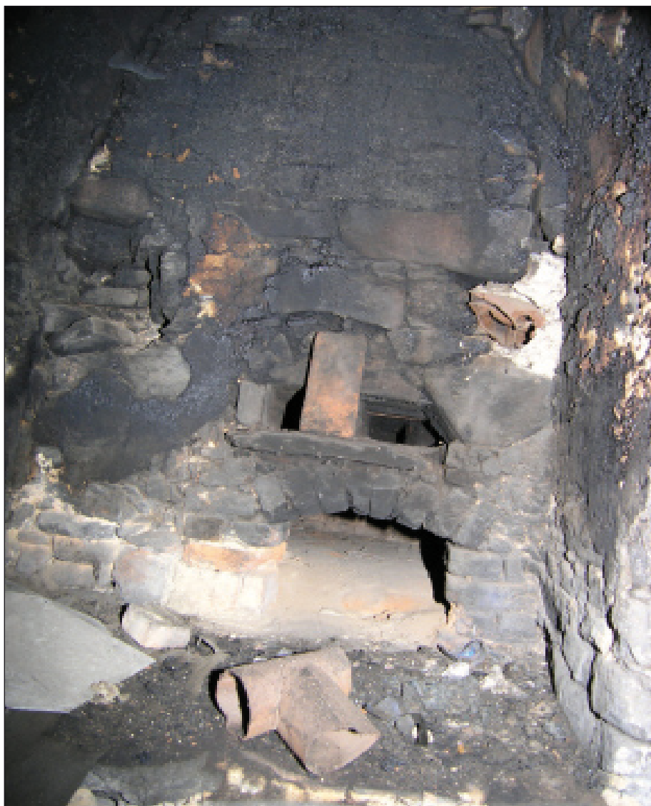
Obr. 12. Radešice čp. 9, vodní mlýn zvaný Jedličkův. Východní stěna černé kuchyně s ústím pece a kouřových sopouchů. Foto 2005.
