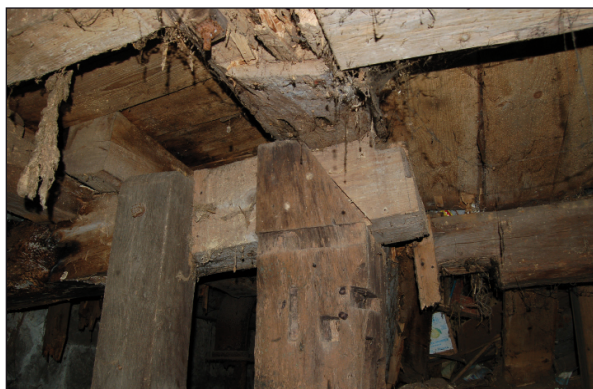
Obr. 12. Turnov, mlýn č.p. 374 (SM), pravý přední sloup S3 a zřejmě mladší svor SV2, foto M. Kolka, 2011.
