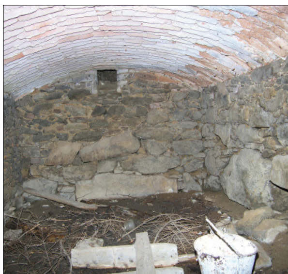
Obr. 17. Radešice čp. 9, vodní mlýn zvaný Jedličkův. Východní část sklepa pod světnicí. Foto 2005.
