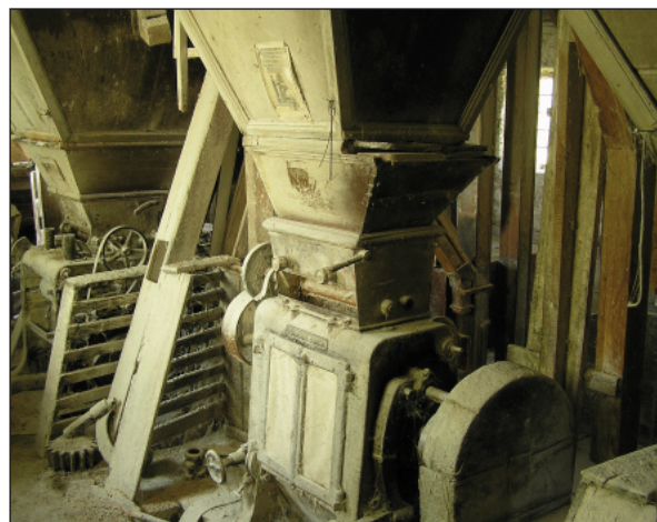
Obr. 16. Mlýn na řece Smotryč ve vsi Kupyn (Chmelnycká oblast), vybavený na přelomu 19. a 20. století turbínou i dalším švýcarským mlýnským zařízením. Foto I. Choma, 2006.
