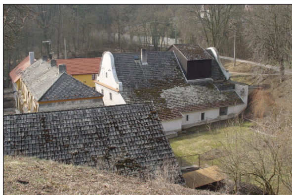
Obr. 2. Choteč čp. 23 (PZ), mlýn Veselých, Pohled na celkový areál mlýna. Foto R. Šimek, 2011.
