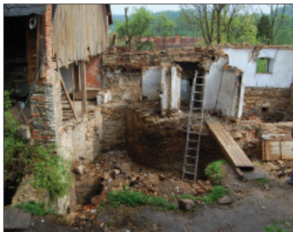
Obr. 31. Radešice čp. 9, vodní mlýn zvaný Jedličkův. Suterén staré mlýnice a černá kuchyně po demontáži roubené konstrukce přízemí. Foto 2009.
