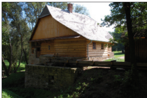
Obr. 37. MVS Vysoký Chlumec, transferovaný mlýn. Pohled od severozápadu. Foto 2011.
