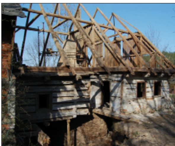
Obr. 28. Radešice čp. 9, vodní mlýn zvaný Jedličkův. Budova mlýna od jihu po zahájení transferu. Foto 2009.
