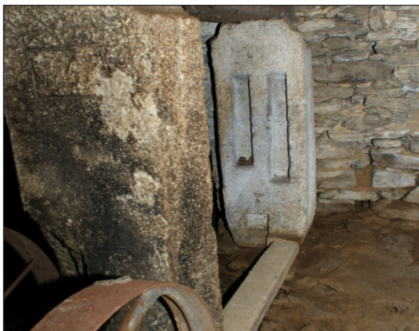
Obr. 5. Mlýn čp. 32 ve Mlýnech (TA). Kamenné sloupky mlýnské hranice s dvěma drážemi pro lehčení, na předním z nich v rámečku vytesaná datace „1861“. Foto R. Urbánek, 2011.
