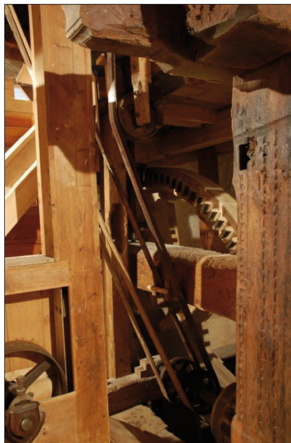
Obr. 56. MVS Vysoký Chlumec, transferovaný mlýn. Suterén, mlýnská hranice a technologické vybavení. Foto 2011.
