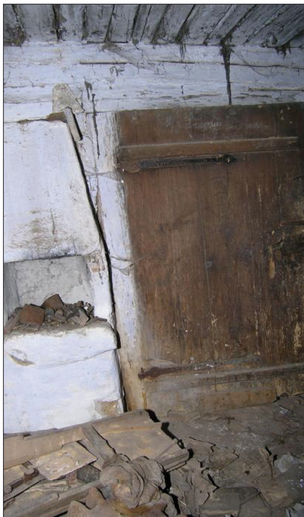
Obr. 14. Radešice čp. 9, vodní mlýn zvaný Jedličkův. Východní stěna zadní světnice se vstupem ze síně a krbečkem ve zděném tělese černé kuchyně. Foto 2005.
