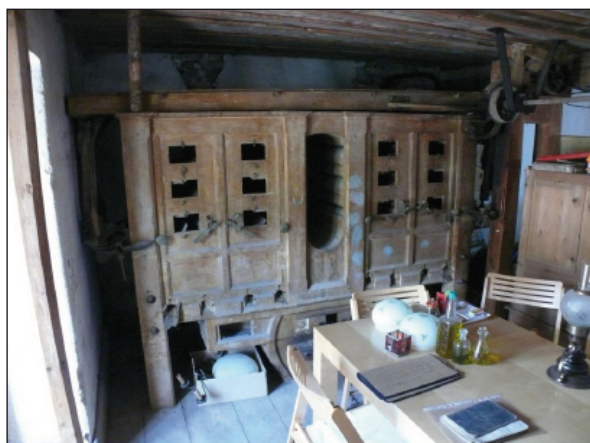
Obr. 10. Pustověty čp. 7 (RA). Interiér mlýnice, savka. Foto I. Minář, 2011.
