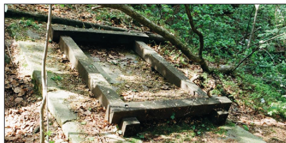
Obr. 6. Lom Johnsorf, Horní Lužice. Skluzavka na spouštění hrubě opracovaných kamenů dolu do údolí (rekonstrukce dřevěných částí). Foto F. Ledvinka, 2011.
