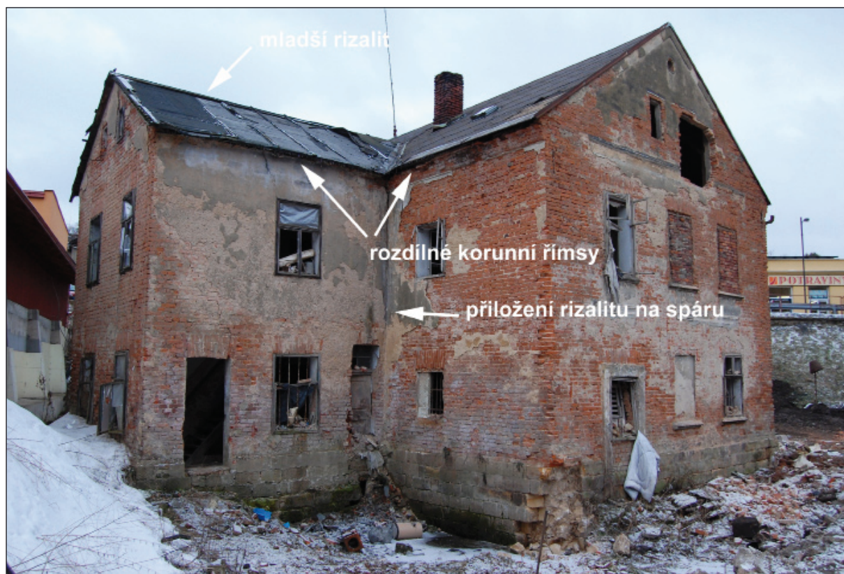
Obr. 2. Turnov, mlýn č. p. 374 (SM). Mladší severovýchodní křídlo přiložené k lednici a k hlavnímu domu mlýna. Foto I. Peřina, 2011.
