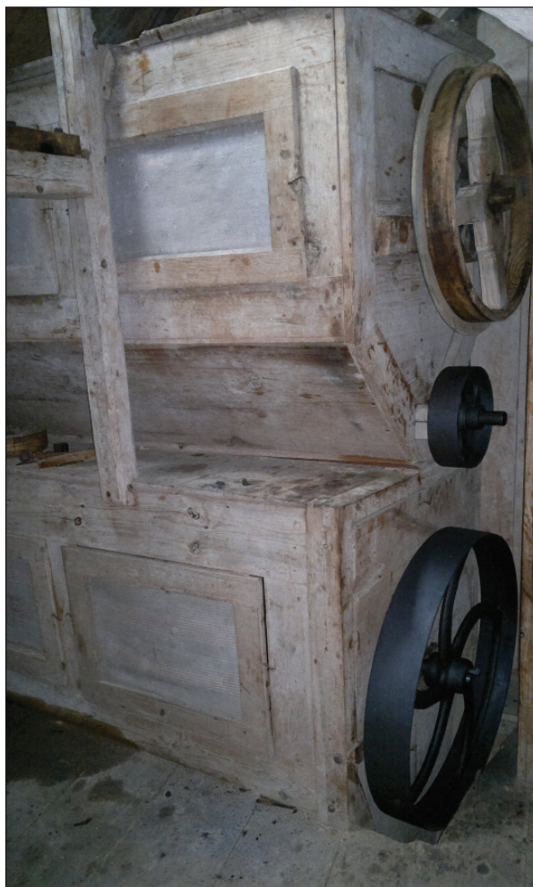
Obr. 9. Mlýn Světce čp. 13 (JH). Hranolový předvysévač se šnekovým dopravníkem (shora), pod ním moučný vysévač. Foto D. Veverka, 2009.
