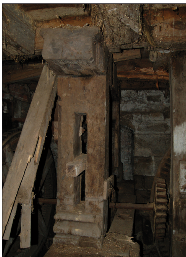
Obr. 8. Turnov, mlýn č. p. 374 (SM). Levá nejstarší část mlýnské hranice, přední sloup s dlabem pro osazení příčky, ve svoru je další dlab pro lehčení mlecích kamenů. Foto M. Kolka, 2011.
