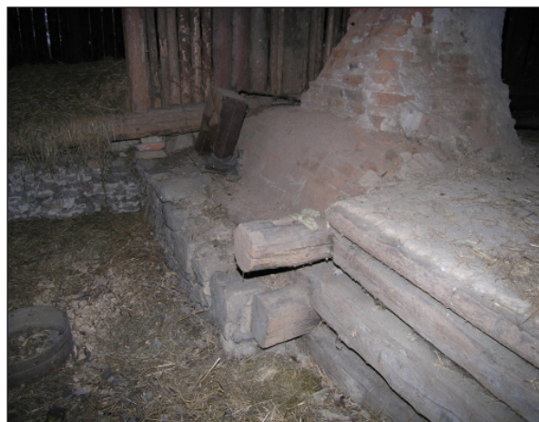
Obr. 19. Radešice čp. 9, vodní mlýn zvaný Jedličkův. Severní stěna černé kuchyně a zadní světnice nad podlahou půdy, na pohledu (ze stropu zadní světničky k východnímu štítu) je patrná klenba černé kuchyně se spodní částí komínu. Foto 2005.
