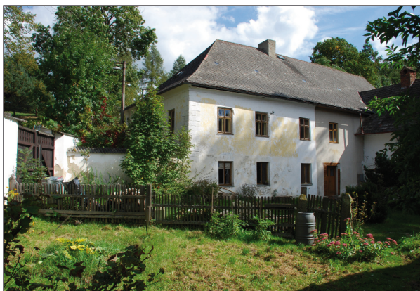
Obr. 5. Kunžak (JH). Celkový pohled na obytné stavení s mlýnicí od severozápadu. Foto J. Pešta, 2010.
