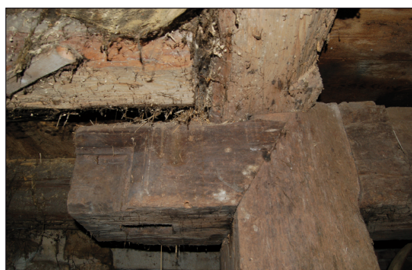
Obr. 9. Turnov, mlýn č. p. 374 (SM). Typický spoj mezi předním sloupem S1 a svorem, nahoře doseďá mladší moučník, vlevo patrná výzdoba svoru a druhotné odřezání shlaví. Foto M. Kolka, 2011.
