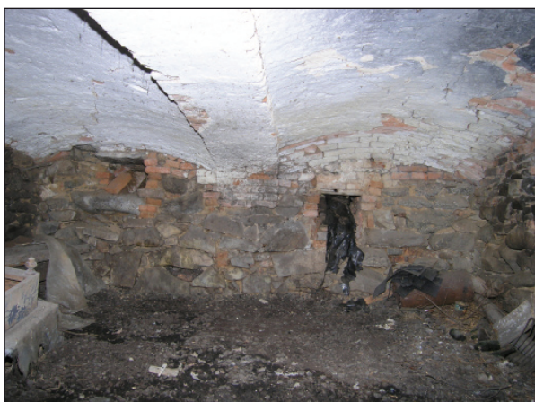
Obr. 16. Radešice čp. 9, vodní mlýn zvaný Jedličkův. Severní část velké stáje v suterénu pod světnicemi. Foto 2005.
