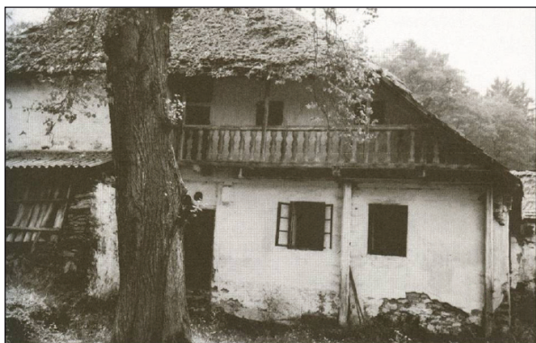
Obr. 7. Hoslovice (ST). Mlýn zmíněný v r. 1352, stav před opravou. Foto L. Štěpán, 2007.
