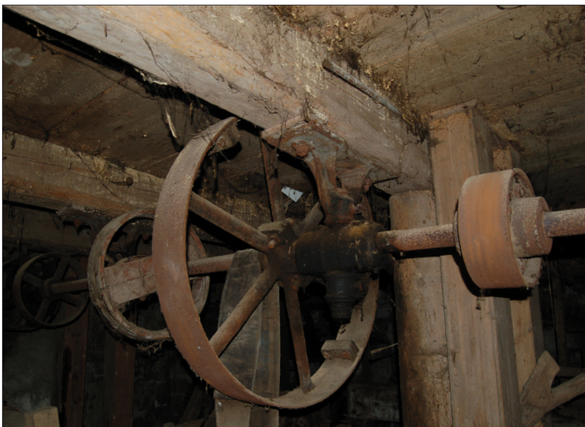
Obr. 16. Turnov, mlýn č. p. 374 (SM), transmise osazená na mladší stropní konstrukci, typické tovární konzoly, foto M. Kolka, 2011.
