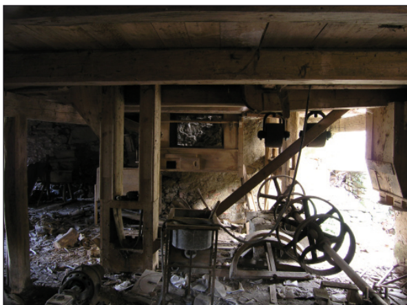
Obr. 24. Radešice čp. 9, vodní mlýn zvaný Jedličkův. Jihovýchodní část suterénu novodobé mlýnice se zbytky technologického vybavení. Foto 2005.
