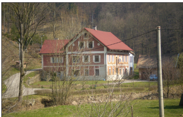
Obr. 7. Kamenice čp. 36 (RK). Foto T. Pavlíčková, 2008.
