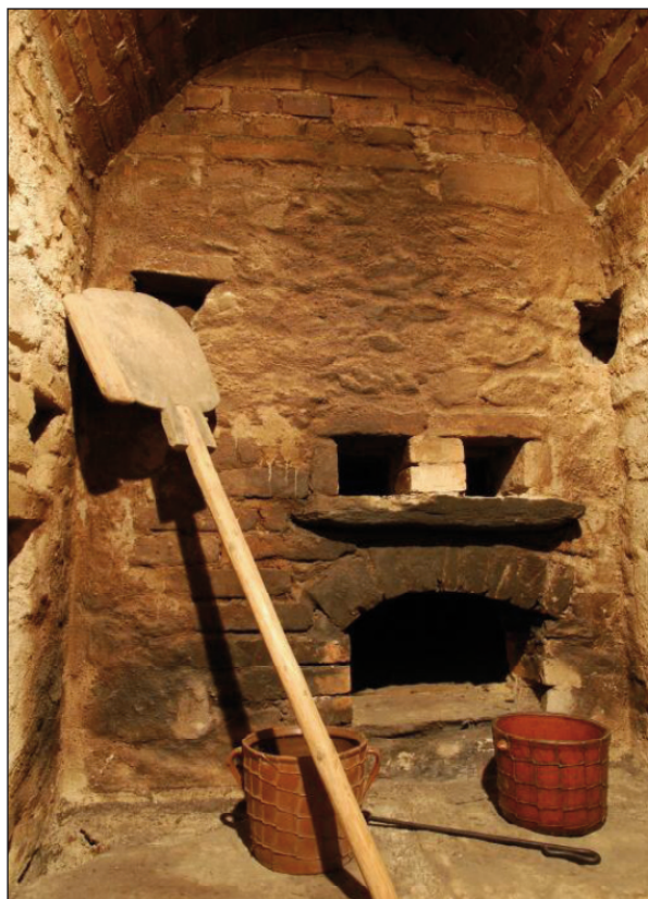
Obr. 42. MVS Vysoký Chlumec, transferovaný mlýn. Stěna černé kuchyně s otvory pro obsluhu pece. Foto 2011.
