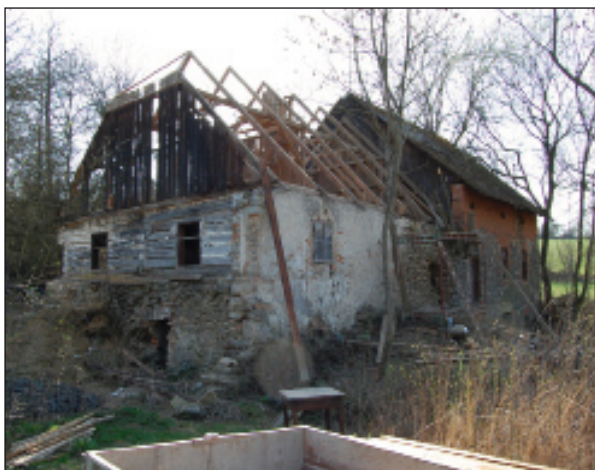
Obr. 30. Radešice čp. 9, vodní mlýn zvaný Jedličkův. Budova mlýna od severovýchodu po zahájení transferu. Foto 2009.
