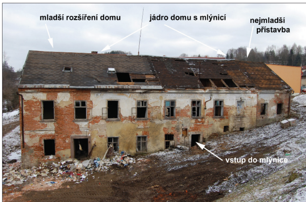
Obr. 1. Turnov, mlýn č. p. 374 (SM). Celkový pohled na budovu mlýna od západu s naznačením rozrůstáním domu. Foto I. Peřina, 2011.
