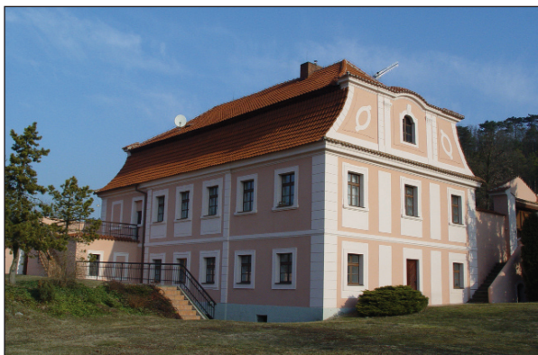
Obr. 1. Sazené čp. 35 (KL), bývalý klášterní mlýn. Pohled na mlýn ze zahrady. Foto R. Šimek, 2011.
