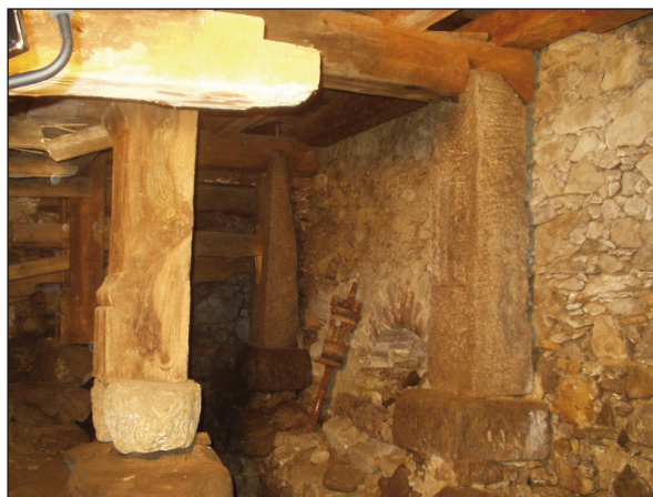
Obr. 8. Třemešná čp. 6 (TA). Dva kamenné sloupy mlýnské hranice, jeden s jednou a druhý se dvěma drážemi pro lehčení. Foto F. Mikyška, 2007.
