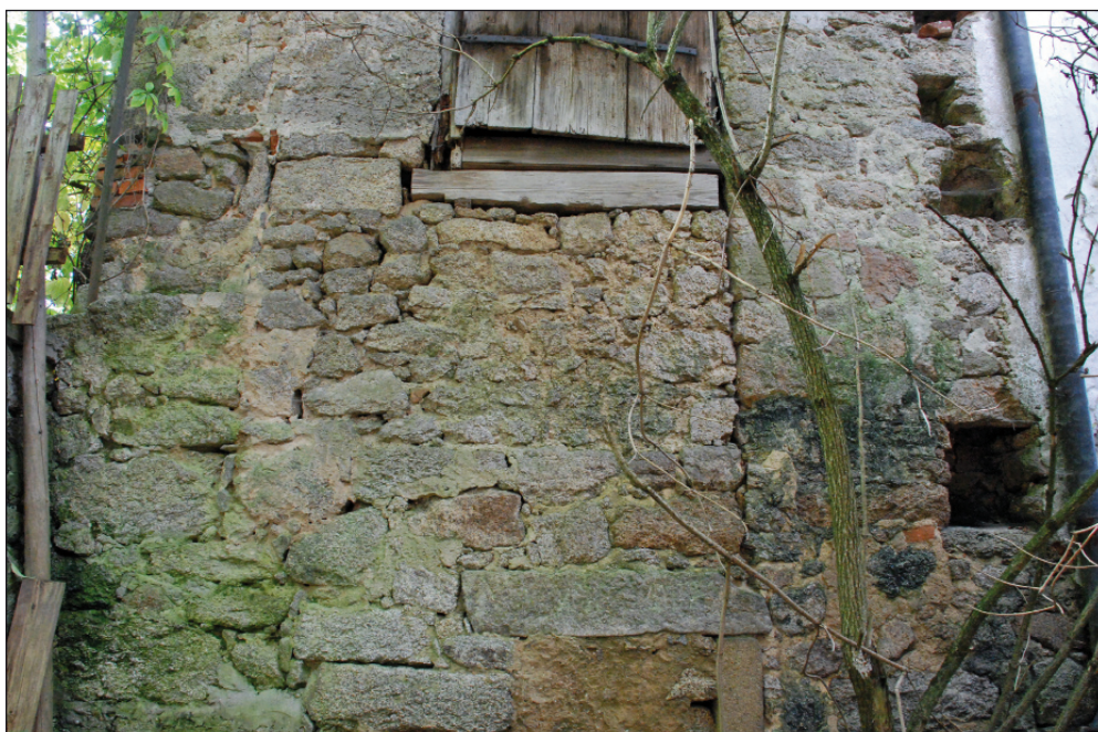
Obr. 9. Kunžak (JH) mlýn čp. 113. Východní průčelí mlýnice s patrnou vertikální spárou, oddělující dvě stavební etapy. Foto J. Pešta, 2010.
