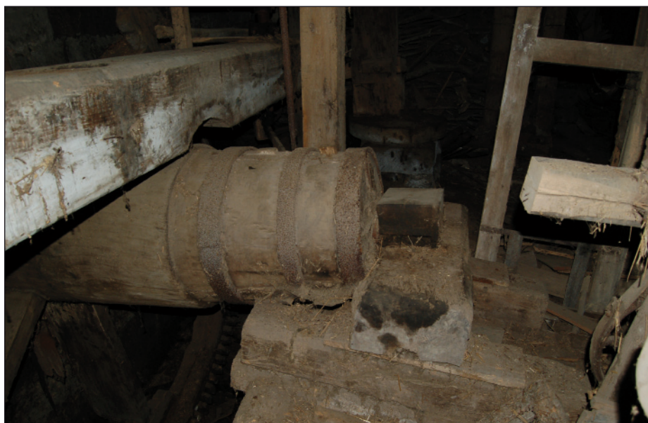
Obr. 14. Turnov, mlýn č. p. 374 (SM), tradiční sestava shlaví hřídele v mlýnici – okovaný čep hřídele, shlaví, shlavíčko a podpůrné trámky – remlíky, foto M. Kolka, 2011.
