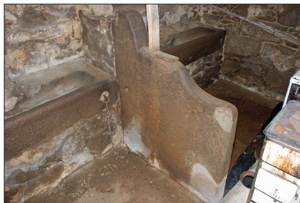
Obr. 15. Kunžak (JH) mlýn čp. 113. Interiér chlěva v jižním křídle s kamennými přepážkami z žulových desek. Foto J. Pešta, 2010.
