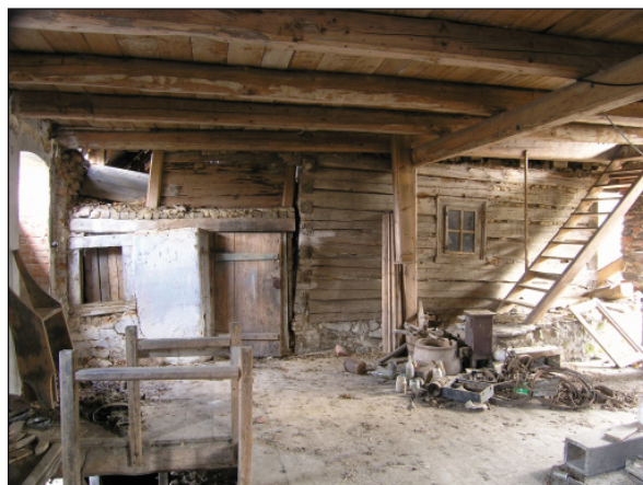
Obr. 25. Radešice čp. 9, vodní mlýn zvaný Jedličkův. Východní část přízemí novodobé mlýnice s pohledem na západní průčelí domu. Foto 2005.
