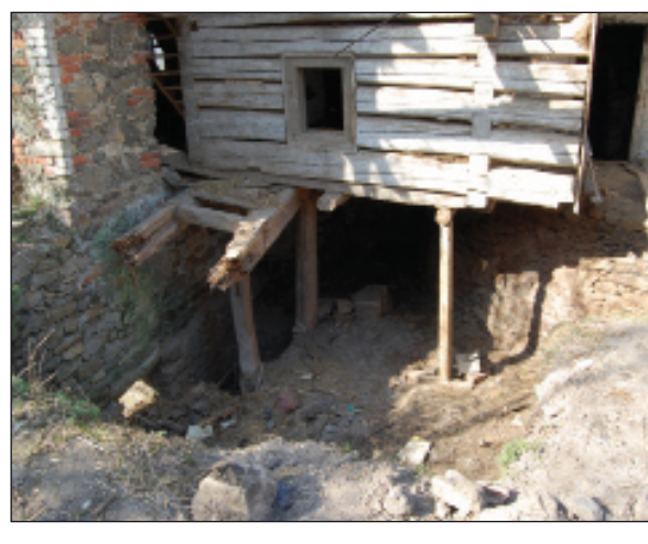
Obr. 29. Radešice čp. 9, vodní mlýn zvaný Jedličkův. Částečně odkrytý suterén staré mlýnice s fragmentem mlýnské hranice (?) a prostorem pro paleční kolo. Foto 2009.
