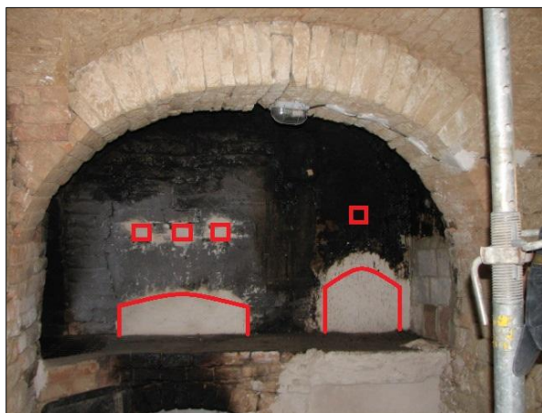
Obr. 1. Mravín (okr. CR), čp. 3, zachycená zadní strana kuchyňské niky s charakteristickou sestavou vstupů do otopných zařízení umístěných ve světnici, zleva pec, kamna, první polovina 19. století. Foto Z. Vařeková, 2013.
