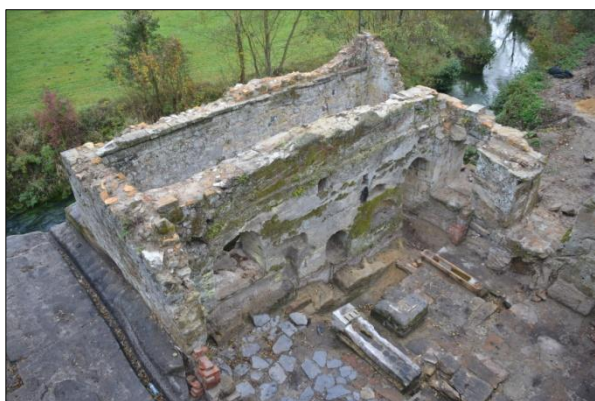
Obr. 15. Celkový pohled na stoupu ze skalního plató od jihu, obvodové zdivo lednice s patkou pro osazení segmentové klenby, vpředu interiér výrobního zařízení, u obvodové stěny odvodňovací žlab vysekaný v pískovcovém podloží. Foto I. Peřina, 2012.
