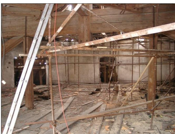
Obr. 10. První opravy žentouru. Foto M. Starec, 2006.
