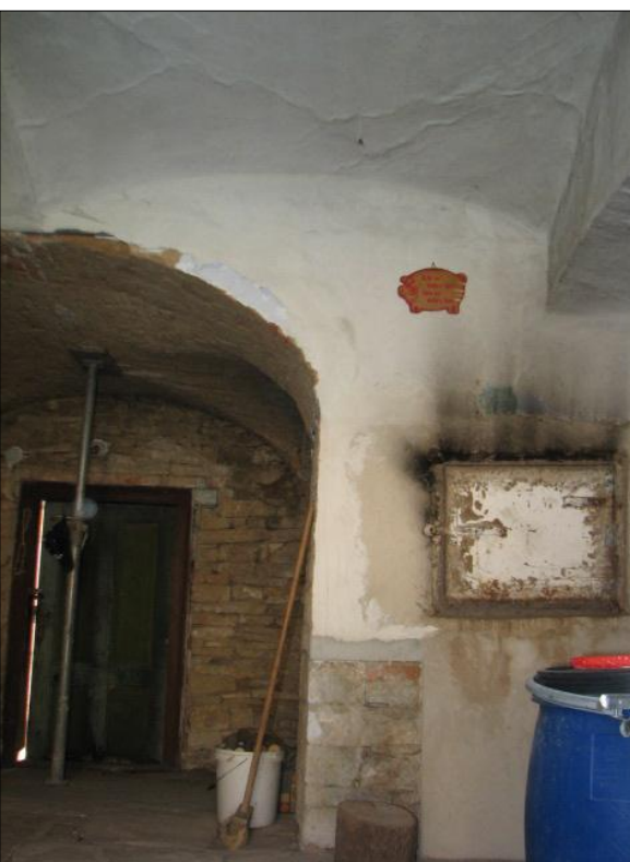
Obr. 3. Hrušová (okr. UO), čp. 10, druhá chlebová pec. Spodní dvířka sloužila k vybírání popela pod roštem. Zasouvateľná dvířka od komory pece zajišťovala přímé vytápění, sázení a vytahování vsázky. Nejvyšší otvor umožnil k vymetání a nastavení tahu plechovými zátkami v každém sopouchu. Foto R. Urbánek, 2012.
