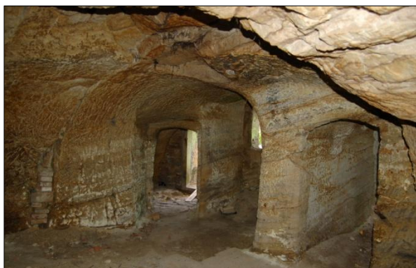
Obr. 6. Interiér zadního chléva zahluobeného do pískovcového podloží, vpravo dveřní otvor spojovací chodby s domem, vlevo dveřní otvor do předního chléva se samostatným vstupem. Foto M. Kolka, 2012.
