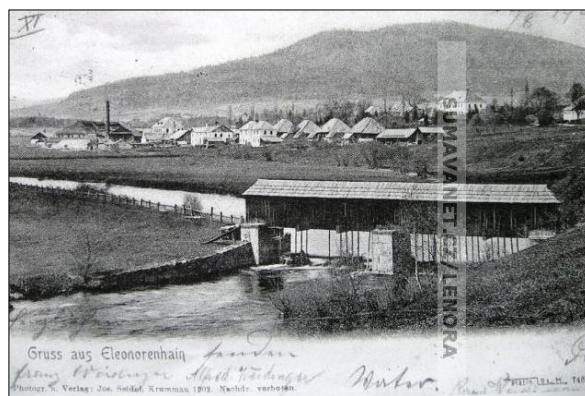
Obr. 4. Rechle Lenoře, funkční stav. Na obrázku je zřejmý systém svislých tyčí a základ sestavovaného voru. Pohlednice z r. 1902, zdroj: www.sumavanet.cz/lenora (7. 12. 2014).
