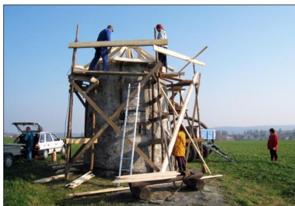
Obr. 6. Nová střecha mlýna. Foto J. Doubek, 2008.
