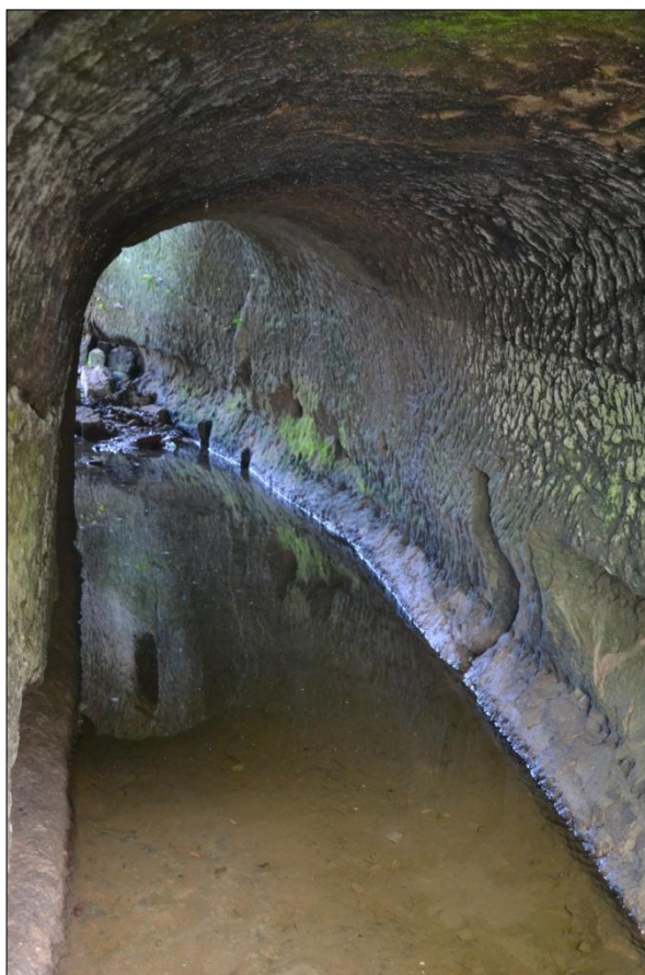
Obr. 13. Detail skalní štoly odtokového kanálu od vyústění směrem k lednici. Foto M. Kolka, 2012.
