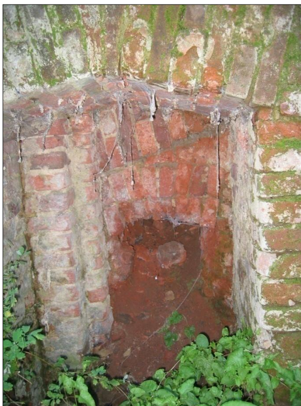
Obr. 9. Praha - Libeň, Pod Labuťkou čp. 391/4, objekt s tehliarskou pecou. Pohľad do južnej manipulačnej niky s otvorom na prikladanie paliva a nábehu oblúka predpokladaného roštu. Foto J. Čáni, 2013.
