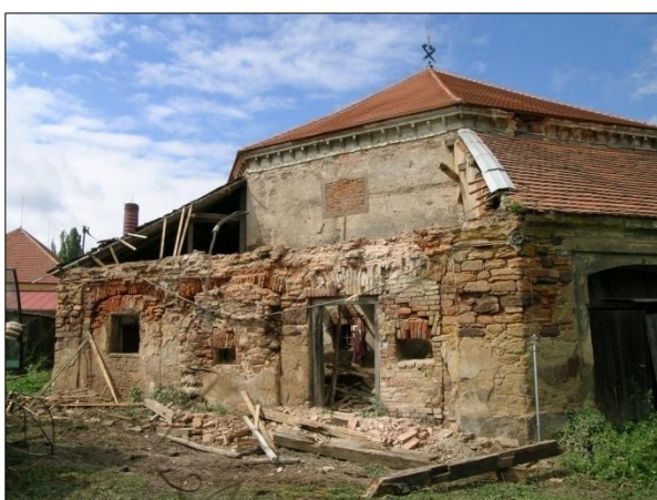
Obr. 9. První opravy žentouru. Foto M. Starec, 2005.
