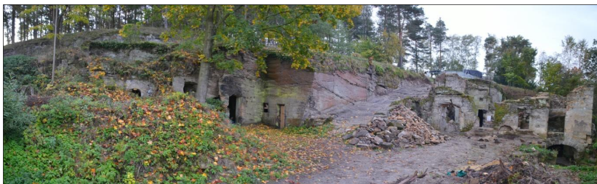
Obr. 3. Celkový pohled na areál usedlosti čp. 95, vlevo zaniklý dům u lomové stěny, vozová cesta a vpravo objekt stoupy. Foto I. Peřina, 2012.
