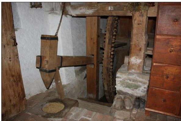
Obr. 7. Na svém místě dochovaný štok s atrapou kladivové stoupy ve mlýně v Hoslovicích (ST). Foto V. Vojanec, viz http://www.turistika.cz/fotogalerie/39689/stredoveky-vodni-mlyn-hoslovice (9. 12. 2013).
