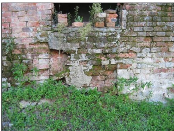
Obr. 7. Praha - Libeň, Pod Labuťkou čp. 391/4, objekt s tehliarskou pecou. Zamurovaná časť južného nakladacieho otvoru. Foto J. Čáni, 2013.
