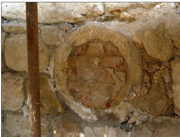
Obr. 8. Štok zazděný v jižní zdi obytné části Satranova mlýna ve Vepřku čp. 19 (ME), Foto R. Šimek. 2011.
