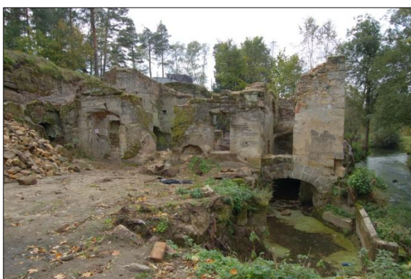
Obr. 8. Celkový pohled na severovýchodní průčelí stoupy s nátokem do lednice. Foto I. Peřina, 2012.
