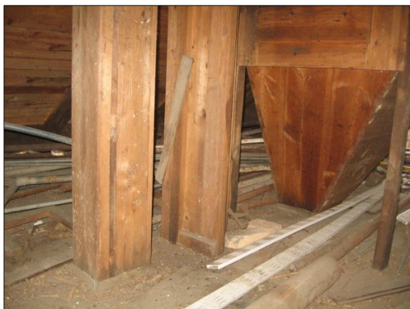
Obr. 8b. Hranolový vysévač v podkroví bývalého mlýnku. 8b – od JV. Foto autor, 2013.
