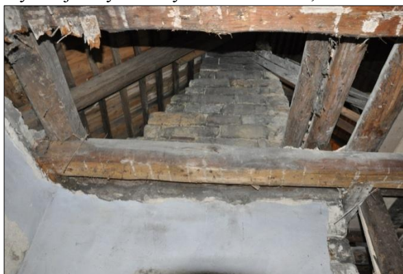
↑ Obr. 15. Frýdštejn čp. 47 (JN). Pas vynášející dymník výhně. Foto autoři, 2011.
