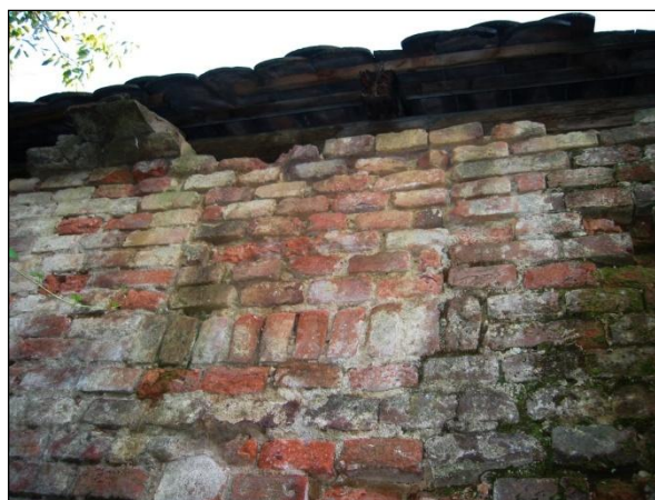
Obr. 8. Praha - Libeň, Pod Labuťkou čp. 391/4, objekt s tehliarskou pecou. Zamurovaná spodná časť severného nakladacieho otvoru. Foto J. Čáni, 2013.
