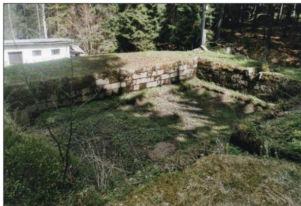
Obr. 9. Karlov (okres Jablonec nad Nisou), brusírna čp. 345, akumulční nádržka na vodu. Foto D. Veverka, 2009.
