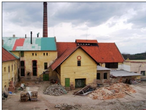
Obr. 6. První stavební odpad. Foto M. Starec, 2004.
