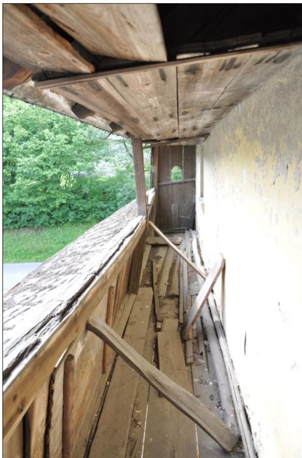
Obr. 7. Frýdštejn čp. 47 (JN). Pohled na pavlač. Foto autoři, 2011.
