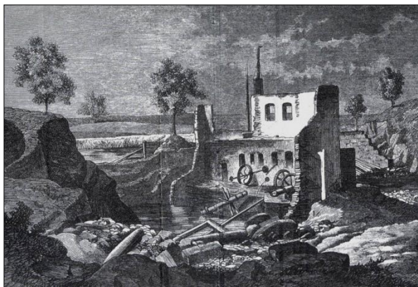
Obr. 12. Hugo Ullík. Zřícená parní pila ve Stebnu. Stěna ve směru proudu pod protrženou hrází vydržela. Zachránili se na ní ve vyšších dvou oknech dva lidé.
