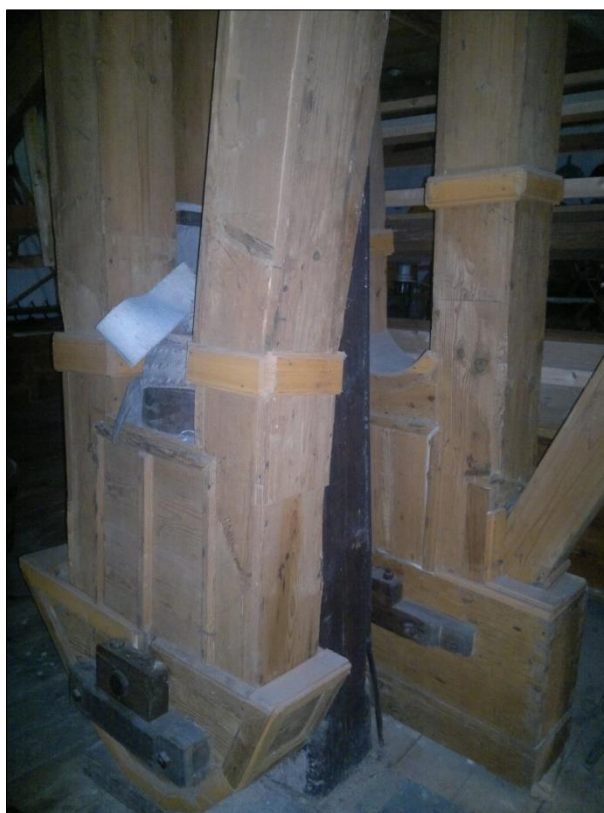
Obr. 17. Karlíkův mlýn, Kozodry čp. 11 (RK), paty kapsových dopravníků, výroba řemeslná z počátku 20. stol. Foto D. Veverka, 2013.
