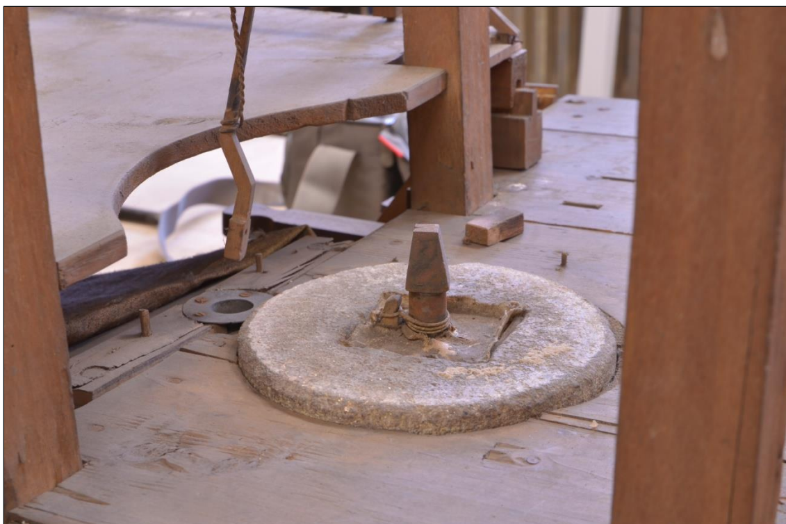
Obr. 8. Na detailu je horní mlecí podlaha s uložením spodního mlecího kamene (ležák). Vedle kamene je hrdlo, kudy prochází melivo do moučnice.
