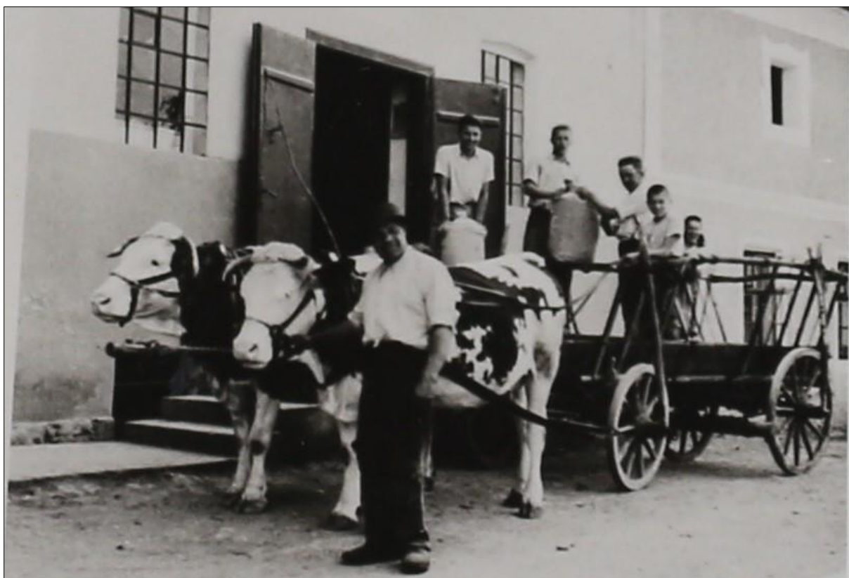
Obr. 5. AF, Evžen Trunkát při nakládání semletého produktu, Želechovice n/Dřevnicí. Archiv P. Gašpárka, 1945.
