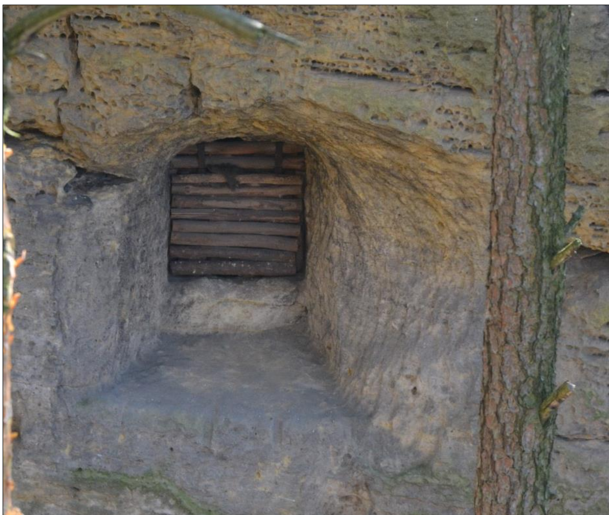
Obr. 21. Kameníkova jizba, detail okna s široce rozevřenými špaletami v severním průčelí světnice. Foto I. Peřina, 2014.
