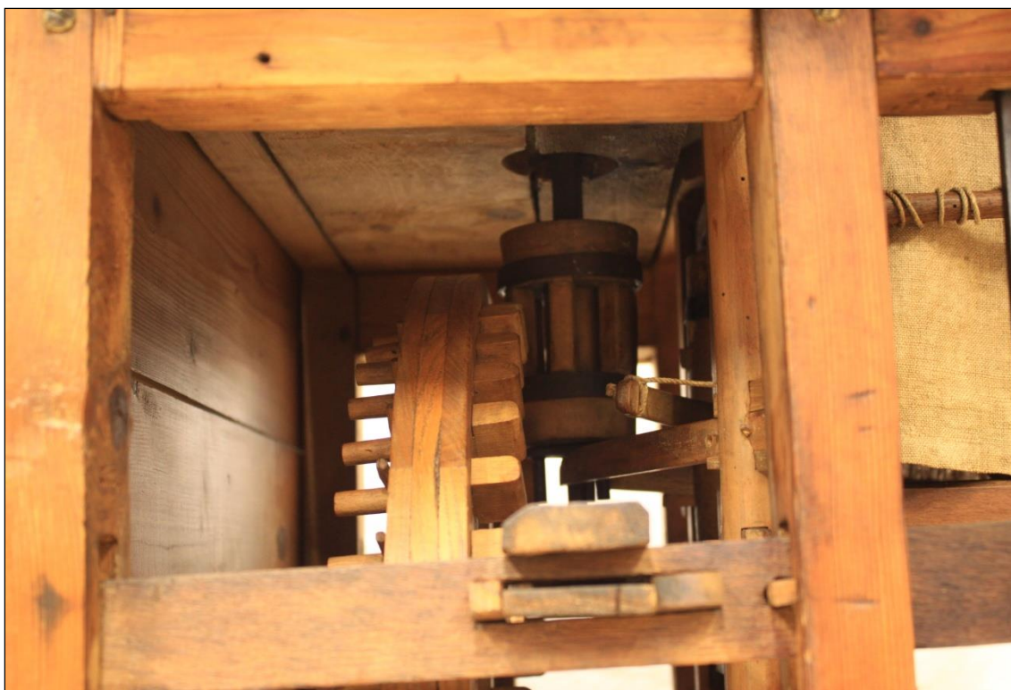
Obr. 40. Detailní pohled na opravené paleční kolo a pastorek.
