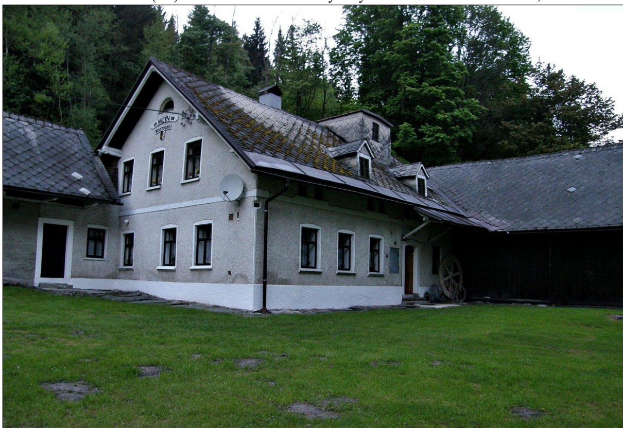
Obr. 8. Roztoky u Semil čp. 42 (SE). Pohled na mlýn od jihovýchodu. Foto P. Špráchal, 2014.
