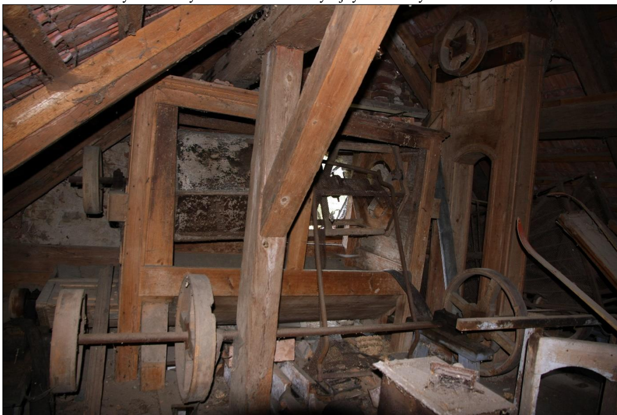
Obr. 35. Votice (BN). Podstřeší mlýna s předvysévačem a hlavou jediného kapsového výtahu. Foto R. Šimek, 2014.
