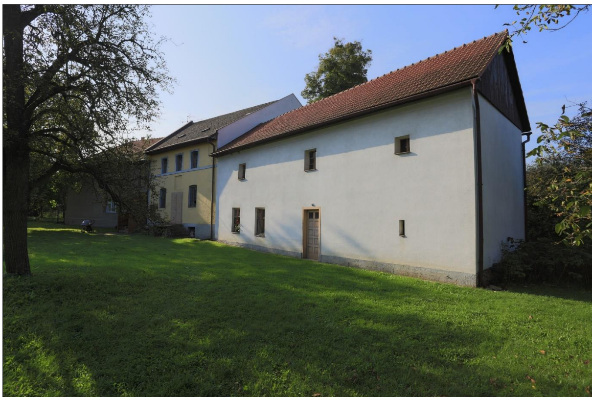
Obr. 10. Pohled severní, zprava: výminek, provozovna mlýna, obytná budova, Želechovice n/Dřevnicí. Foto P. Gašpárek, 2014.
