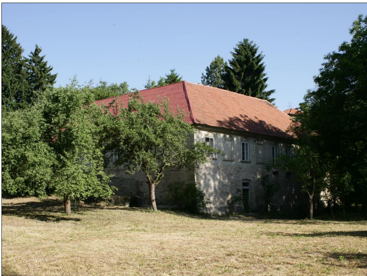
Obr. 38. Kouřim čp. 270 (KO). Celkový pohled na mlýn z jihu. Foto R. Haluska, 2012.
