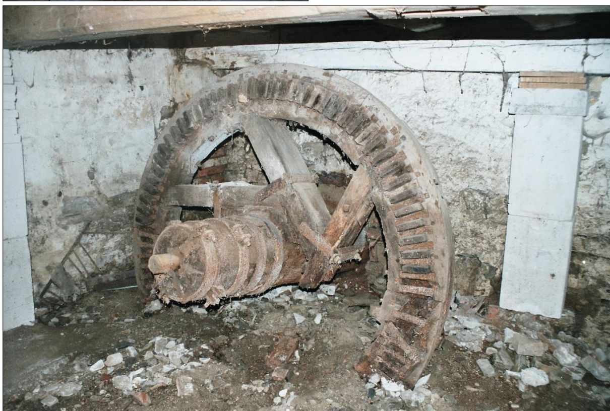
Obr. 21. Podvoletský mlýn, Luže čp. 118 (CR), paleční kolo s tzv. přesazovanými rameny, výroba řemeslná v počátku 20. stol. Foto D. Veverka, 2008.
