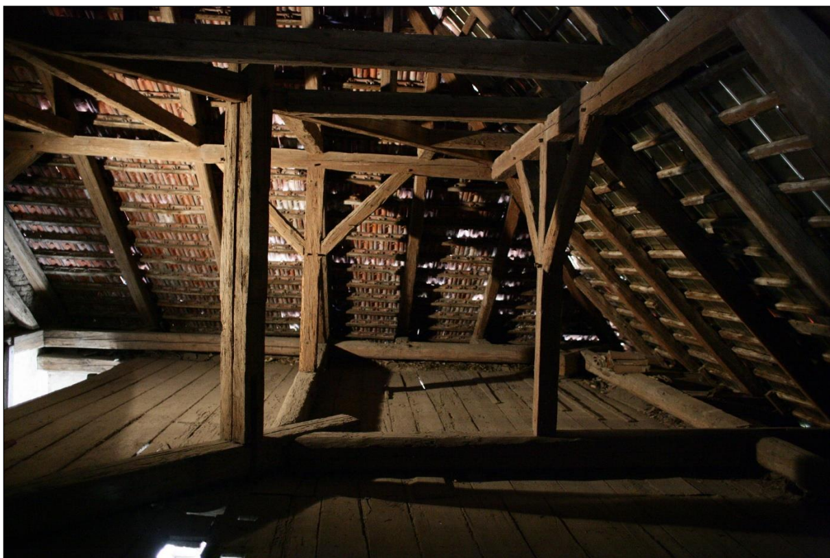
Obr. 43. Kouřim (KO). Pohled od podstřeší. V popředí otvory po kapsovém výťahu. Foto R. Haluska, 2012.
