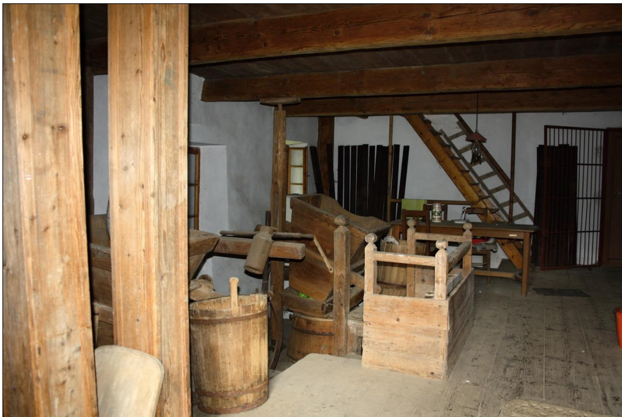
Obr. 34. Votice (BN). Pohled na mlecí podlahu. V popředí jediný kapsový výtah, za ním kamenné složení s francouzskými kameny a druhé složení s obyčejnými kameny. Foto H. Růžencová, 2014.
