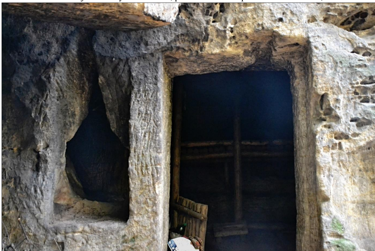
Obr. 19. Kameníkova jizba, pohled na nakládací otvor a odtah topeniště v sousedství vstupu z černé kuchyně do světnice. Odtah dýmu z černé kuchyně zajišťuje přirozený tah vzduchu ve vertikální puklině. Foto I. Peřina, 2014.
